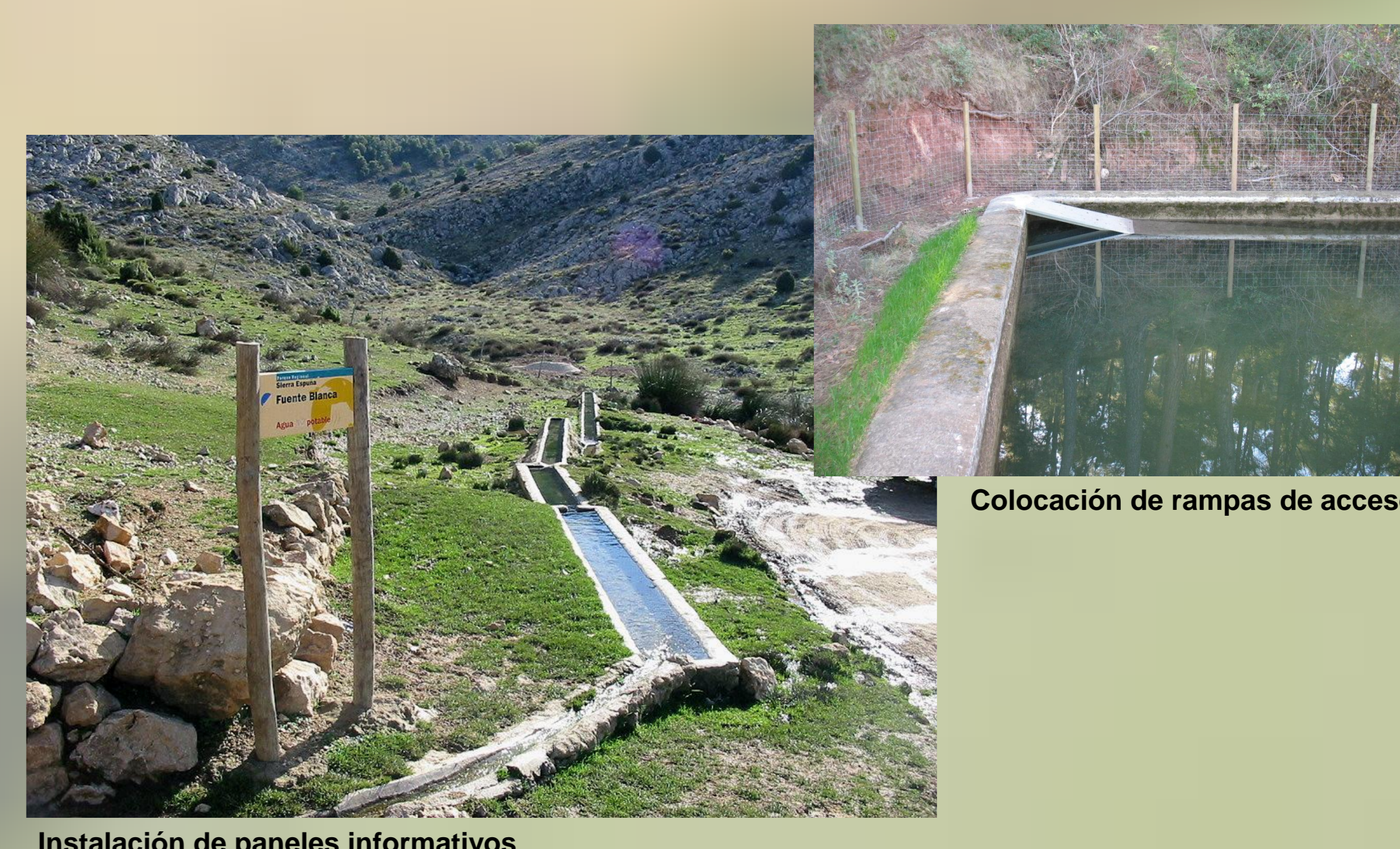
Instalación de paneles informativos
